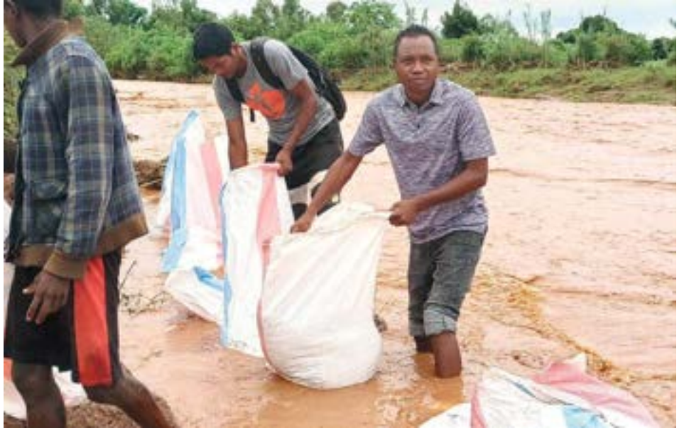
Le Député Rakotondrazafy José Alain pendant les travaux d'urgence de la digue de Manamontana
